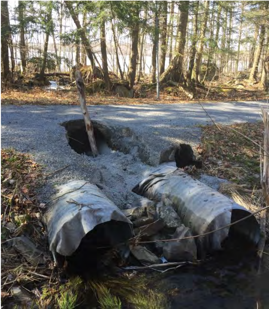
2) KM 16 : Juste avant le KM 16 entre le barrage et l'atelier (Affaissement majeur de la piste sur la calvette double)
