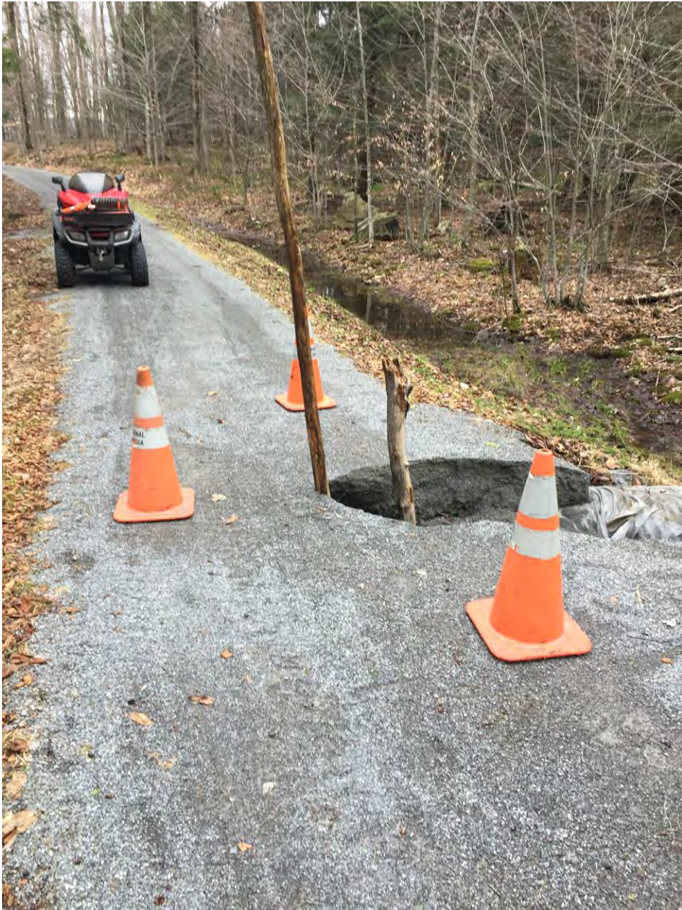
2) KM 16 : Juste avant le KM 16 entre le barrage et l'atelier (Affaissement majeur de la piste sur la calvette double)
